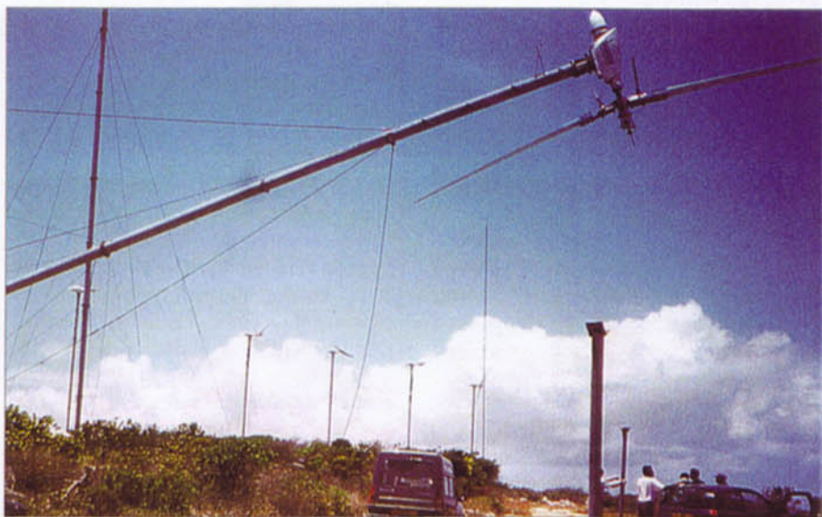
▲ A Grande-Terre, les 140 éoliennes bipales de 2,5 tonnes de la centrale de Petit-Canal, ▲ montées sur des mâts de 30 à 40 mètres, se couchent en cas d'alerte cyclonique.
