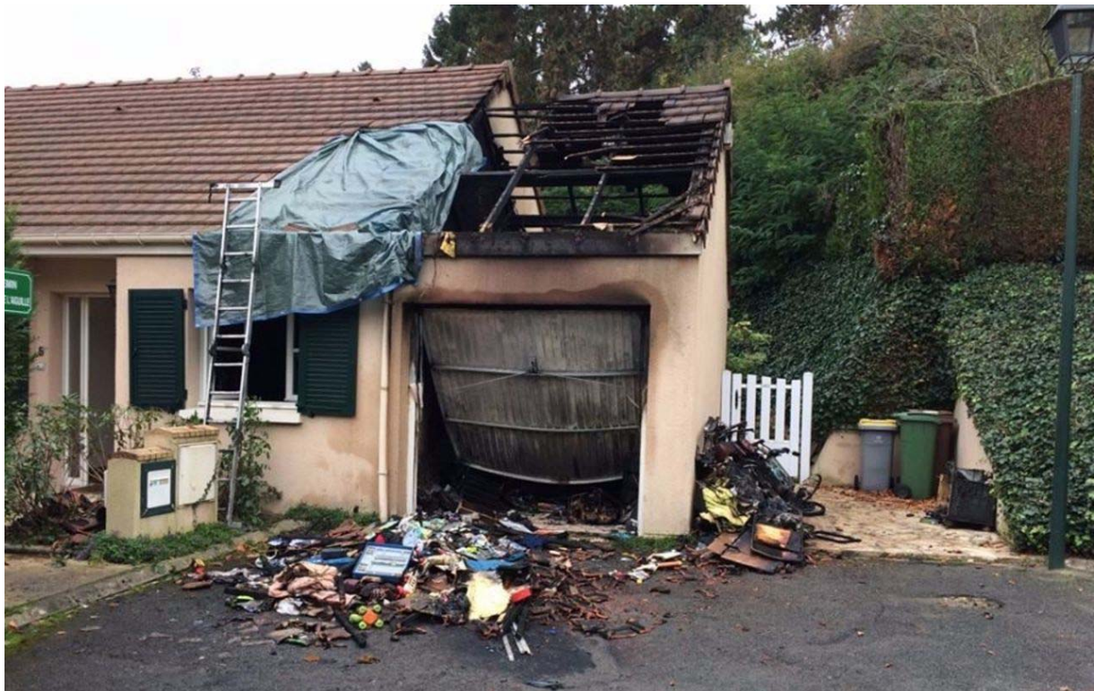
Le garage a été entièrement détruit, tout comme la cuisine. LP/L.D.
